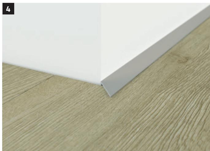
Die einzelnen Leisten werden **VOR** der Verlegung **OHNE** Kleber „anprobiert“. Wenn alles passt, werden die Profile wieder entfernt und mit der Verklebung begonnen.
