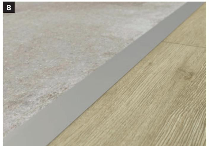
Das Übergangsprofil ist montiert. Nach einer kurzen Kontrolle kann das nächste Teilstück montiert werden.
