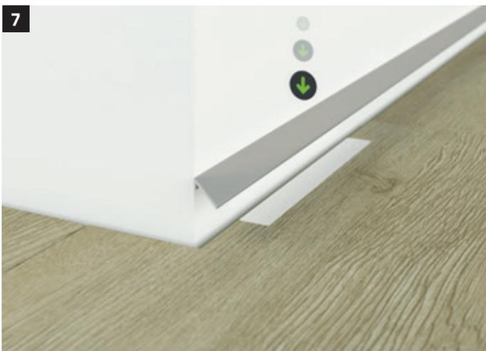
Nun kann das Abschlussprofil der Wand entlang geführt und einfach auf die Klebestripes aufgeklebt werden. Die korrekte Positionierung ist wichtig, da nach dem ersten Klebestripe die Leiste nicht mehr parallel zur Wand verschoben werden kann.
