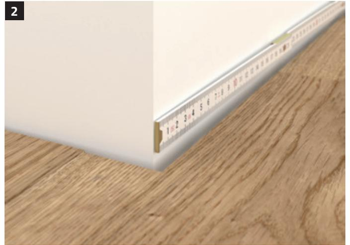
Die Abmessungen für die Profilschnitte werden an den Wandflächen abgenommen. Gehrungsschnitte für Innen- und Außenecken werden hierbei berücksichtigt.
