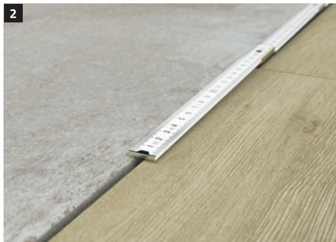
Die Abmessungen für die Profilschnitte werden am Bodenbelag abgenommen. Eventuelle Gehrungsschnitte werden hierbei berücksichtigt.
