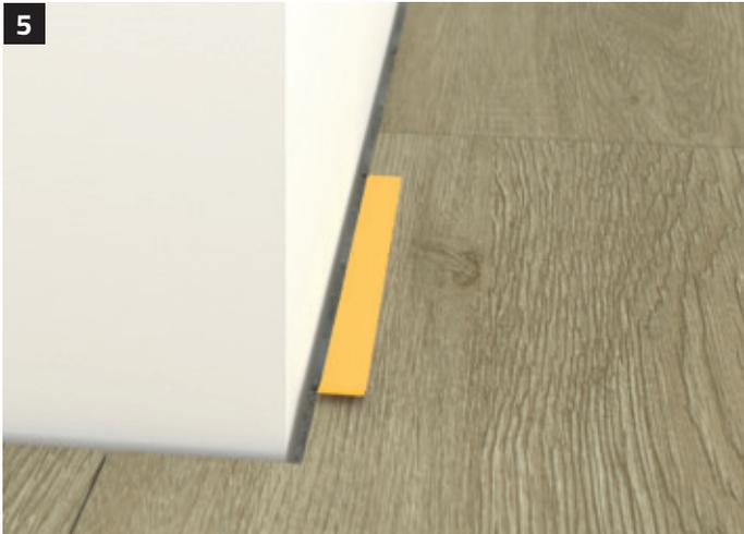
Die einzelnen Klebestripes werden vom Klebebogen abgezogen (Abzuglasche beachten) und zur langen Seite hin bündig mit der Kante der Anschlussfuge auf den Bodenbelag geklebt.
