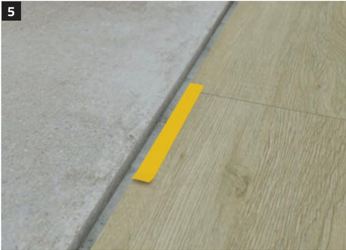
Die einzelnen Klebestripes werden vom Klebebogen abgezogen (Abzuglasche beachten) und einseitig zur langen Seite hin bündig mit der Kante der Übergangsfuge auf den Bodenbelag geklebt.
