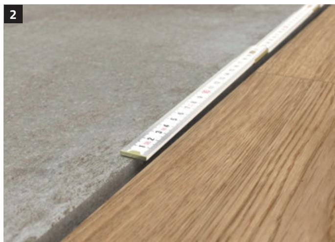
Die Abmessungen für die Profilschnitte werden am Bodenbelag abgenommen. Eventuelle Gehrungsschnitte werden hierbei berücksichtigt.
