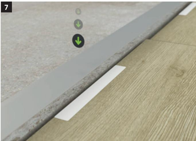
Nun kann das Übergangsprofil einfach auf die Klebestripes aufgeklebt werden. Die korrekte Positionierung ist wichtig, da nach dem ersten Klebestripe die Leiste nicht mehr parallel zur Übergangsfuge verschoben werden kann.
