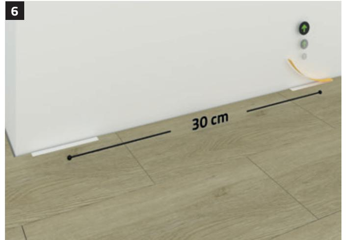
Klebestripes alle 30 cm auf den Bodenbelag lt. Punkt 5 aufkleben. Vor Montage der Abschlussprofile die gelbe Wachsfolie der Klebestripes an der Lasche nach oben abziehen.
