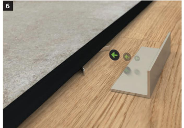
Das Übergangsprofil mit den eingeschobenen Montageclips wird nun in die Übergangsfuge in Montageposition gebracht. Mit der Montagehilfe werden die Montageclips vorsichtig aufgespreizt, indem mit der Montagehilfe die Montageclips Richtung Übergangsprofil gedrückt werden.
