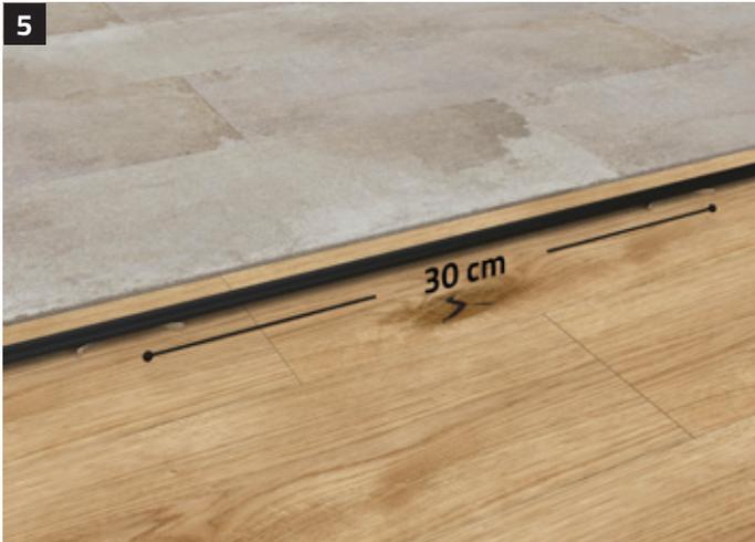
Montageclips alle 30 cm in die Abschlussleiste einsetzen.
